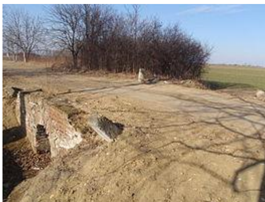
Ívátvágás miatt felhagyott útdarab Gencsapáti mellett. 1940-es évekbeli állapotot mutatja. Falazott áteresz és két-két kerékvető.
